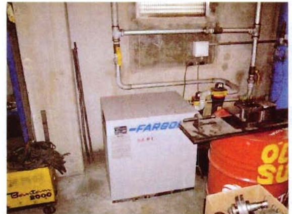
Vista do secador de ar fabricante Fargon nº 21977 tipo THL0700 cap. 475m 3 /h
