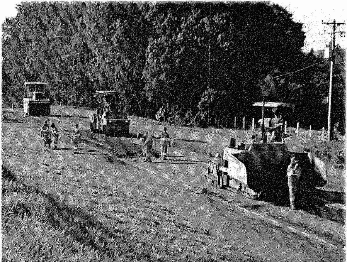
Foto 05: Aplicação e Compactação de CRI D - SP-360/Rota das Bandeiras
