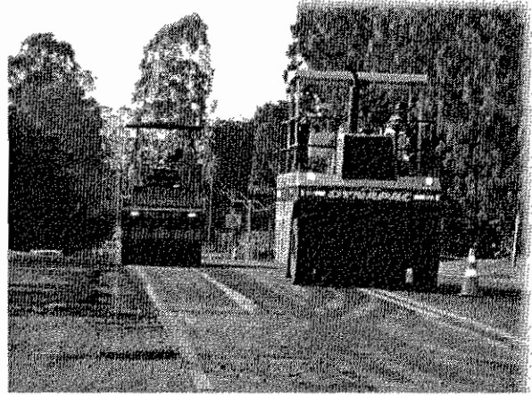
Foto 04: Compactação de CRI D - SP-360/Rota das Bandeiras
