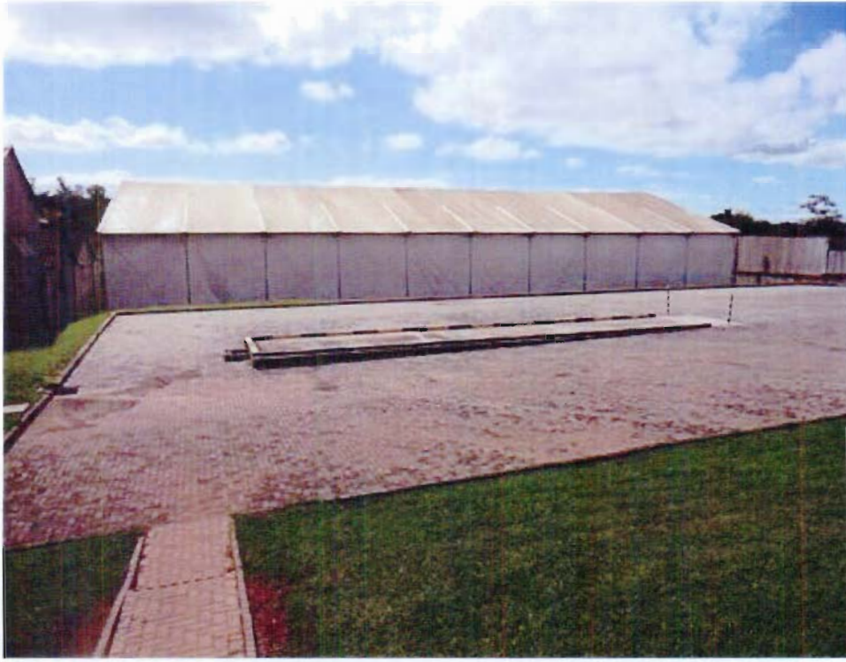
Foto: Vista Geral do Barracão 2 / Balança Rodoviária
