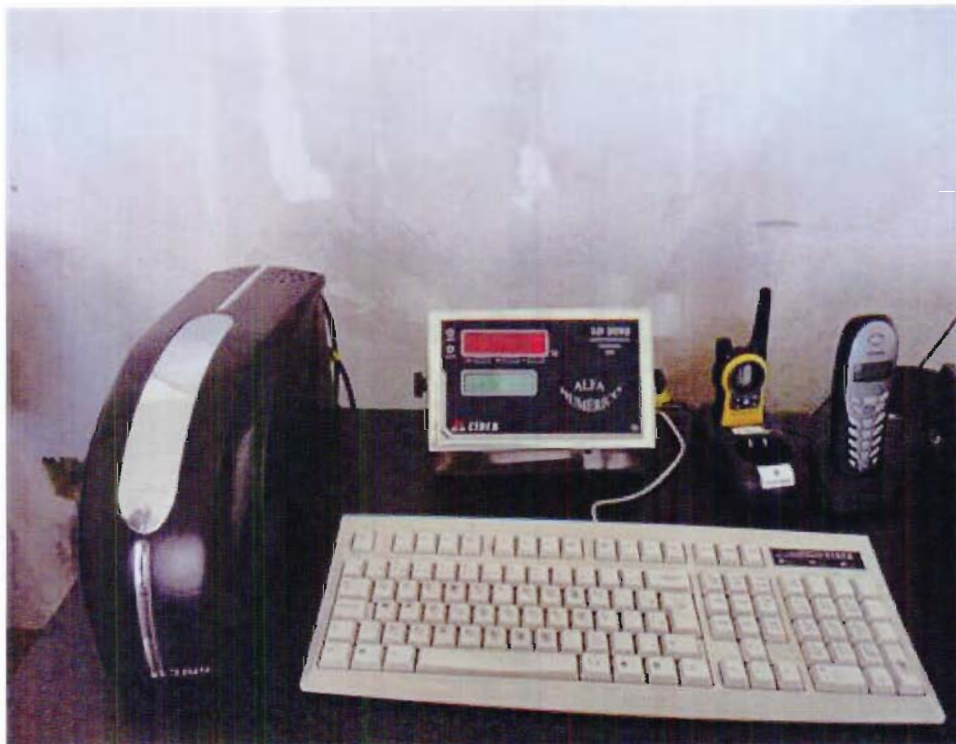
Foto: Vista dos Controles de Pesagem da Balança Rodoviária.
