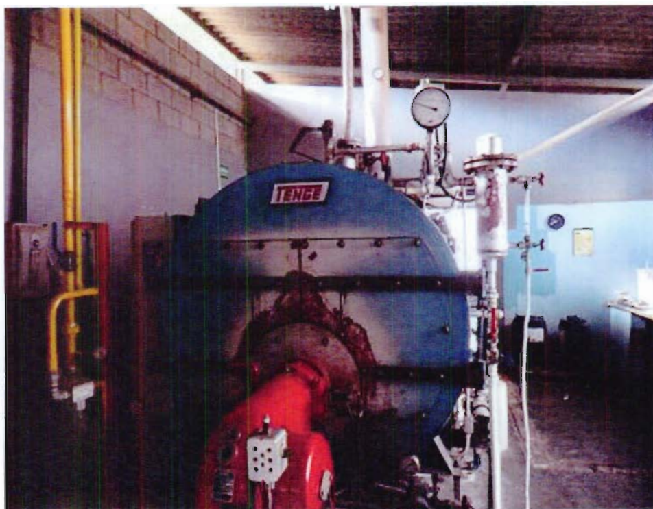
Foto: Caldeira Adaptada a Gás, Marca Tenge.
