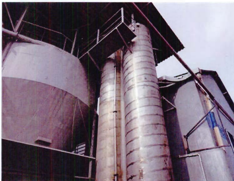
Foto: Vista do Conjunto de Reatores.
