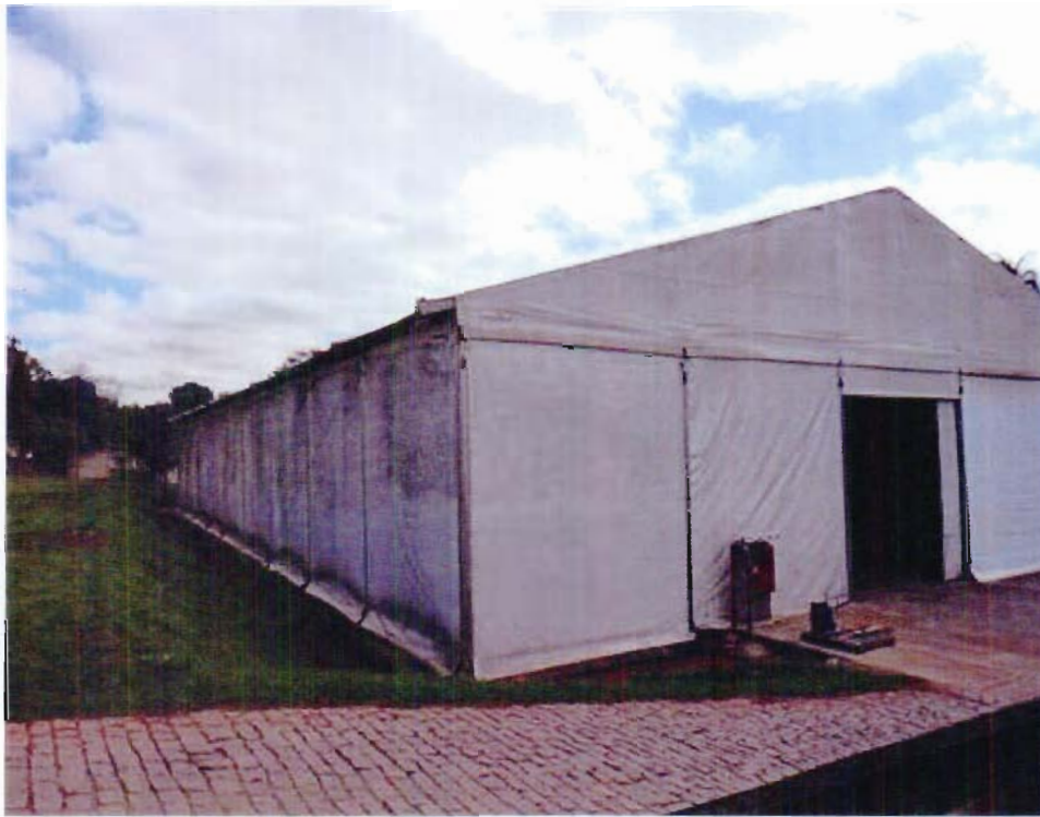
Foto: Vista Externa do Barracão 1.
