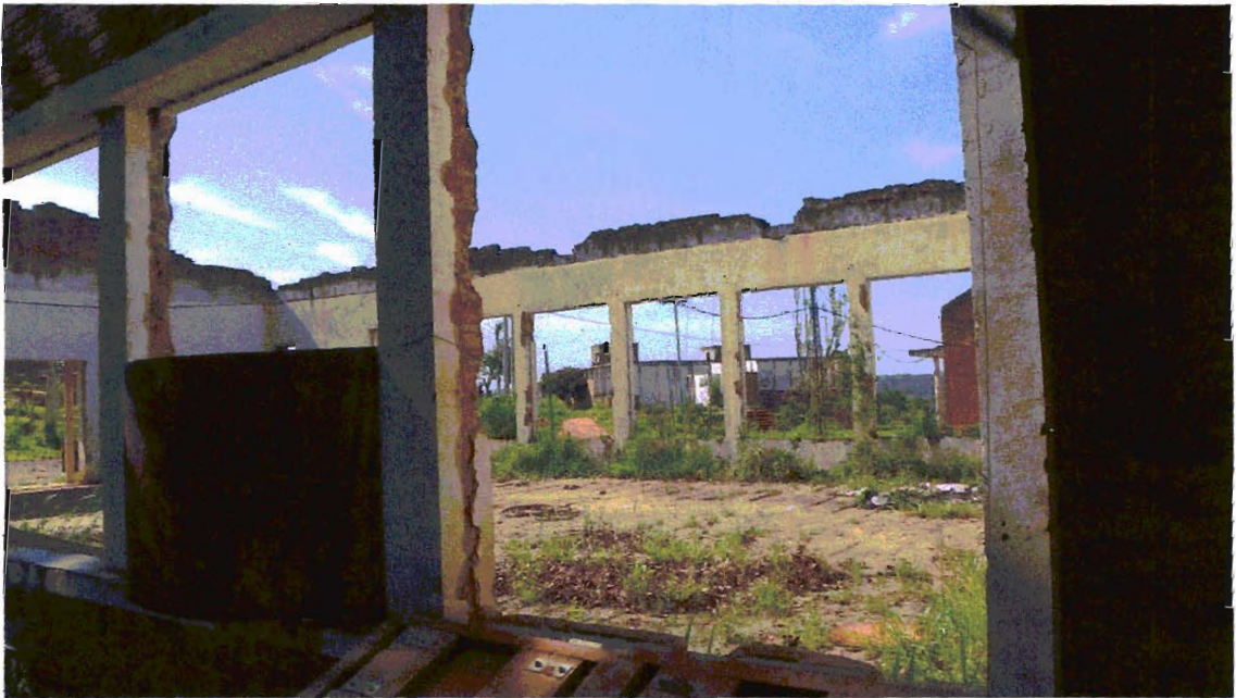
Foto 4. . Escombros dos prédios administrativos que existiam no local - ( 2 )
