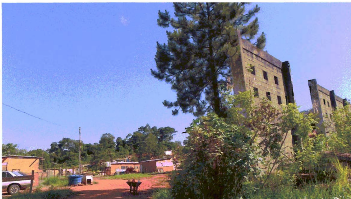
Foto 2. Parede lateral de um dos galpões que existiam no terreno de matrícula nº 57.780
