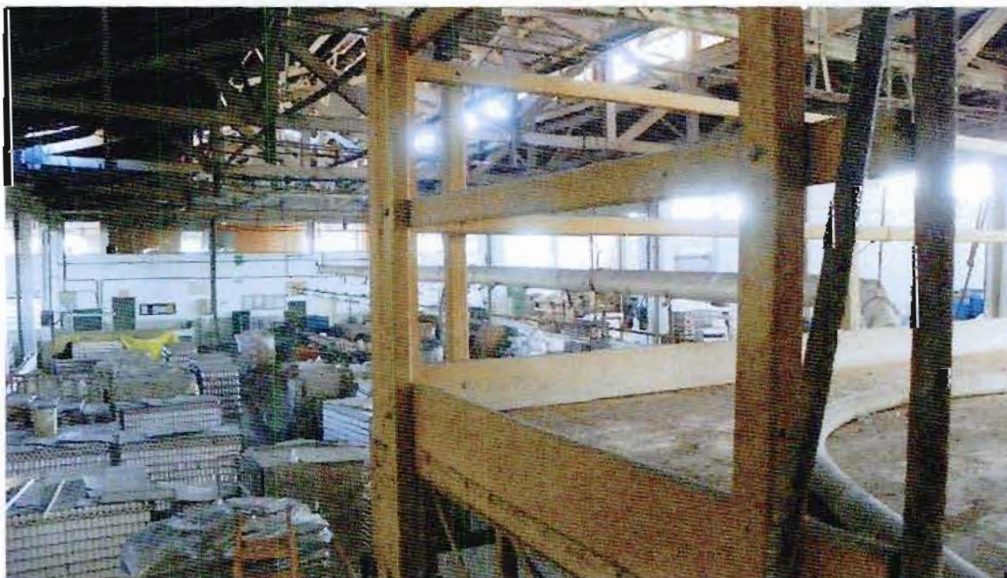
Foto 20. Interior dos galpões, tendo ao fundo, no alto, as janelas da área administrativa -12
