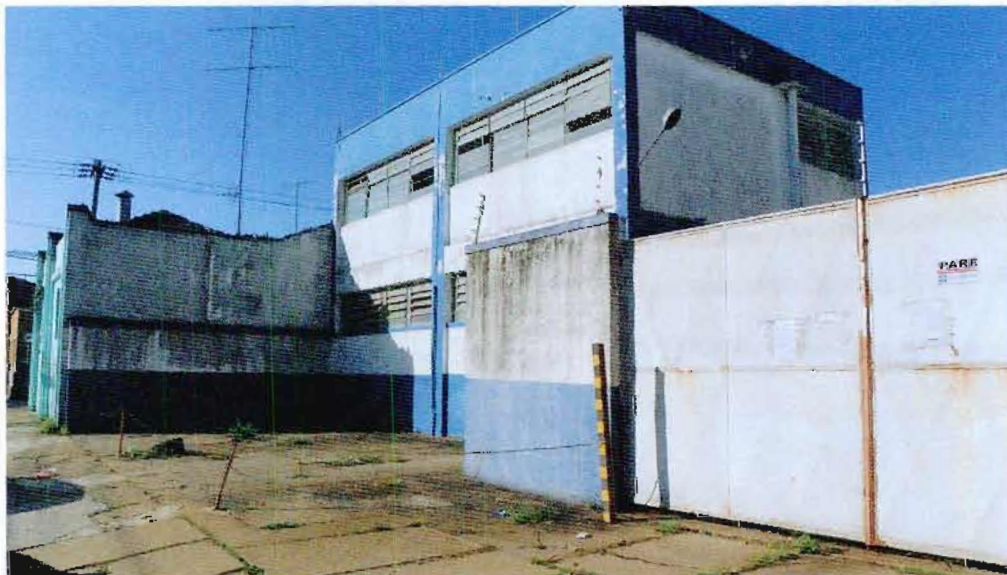
Foto 12. Portão de acesso na rua Santa Maria
