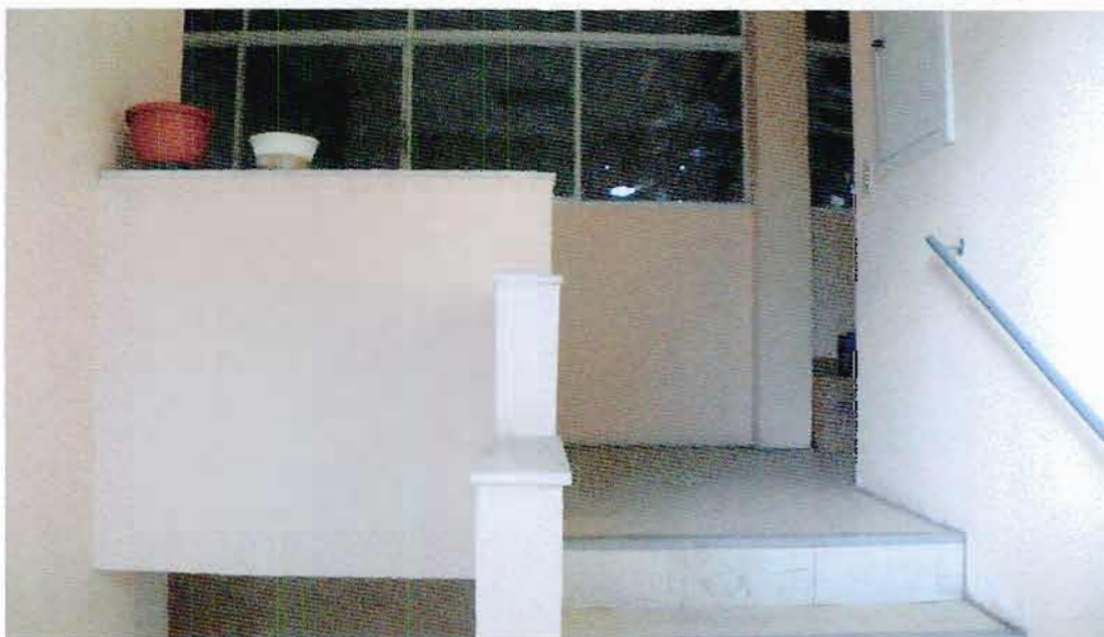
Foto 24. Final da escada no segundo piso. Ao fundo vidraças voltadas para o interior dos galpões
