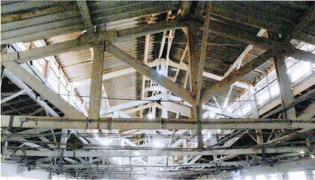
Foto 21. Detalhe da estrutura de cobertura de um dos galpões
