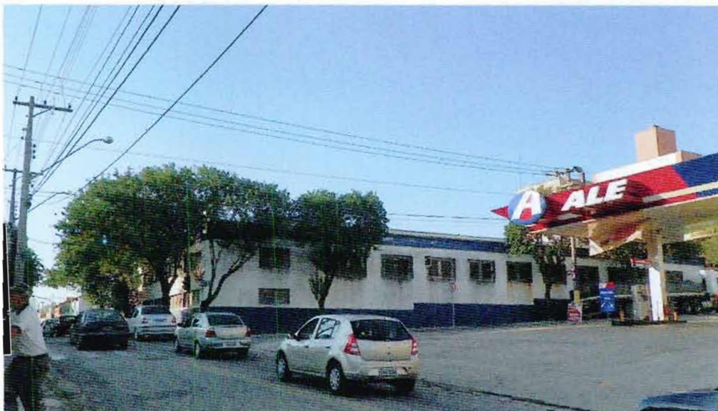
Foto 2. Vista do imóvel avaliando, na esquina das ruas Santa Maria (E) e Joaquim Nabuco (D) - 2
