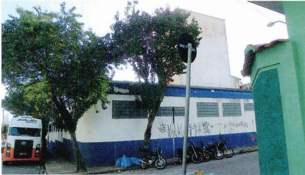
Foto 4. Vista do imóvel avaliando, na esquina das ruas Joaquim Nabuco (E) e Santo Antonio (D) - 2
