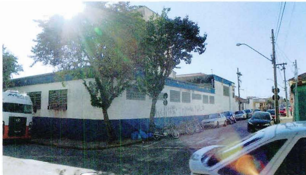
Foto 4. Vista do imóvel avaliando, na esquina das ruas Joaquim Nabuco (E) e Santo Antonio (D) - 1
