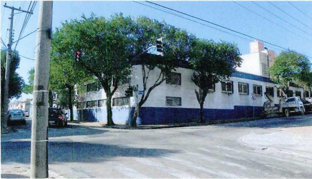
Foto 1. Vista do imóvel avaliando, na esquina das ruas Santa Maria (E) e Joaquim Nabuco (D) - 1
