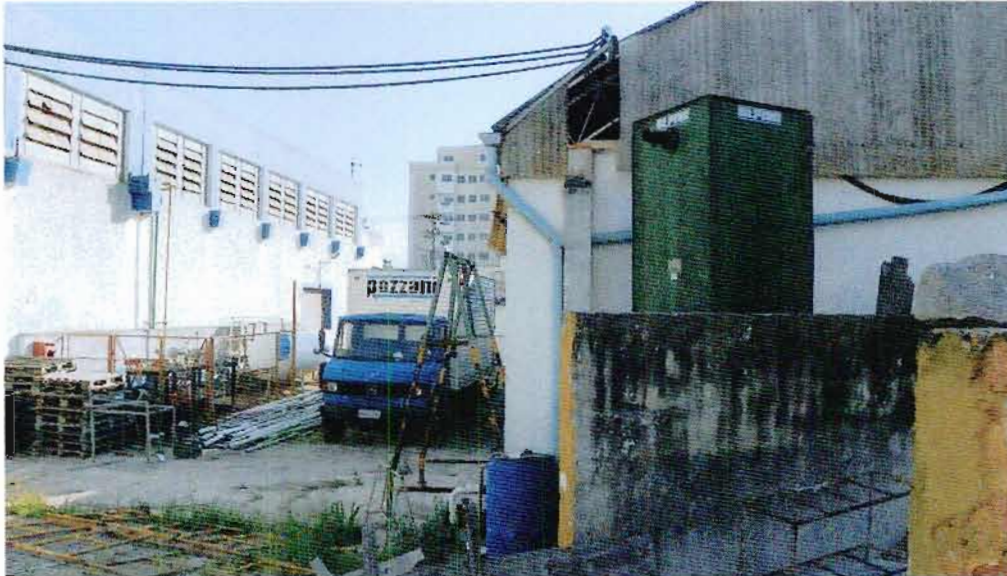
Foto 15. Vista do corredor interno. No horizonte, atrás do prédio, av. Fredenco Ozanan
