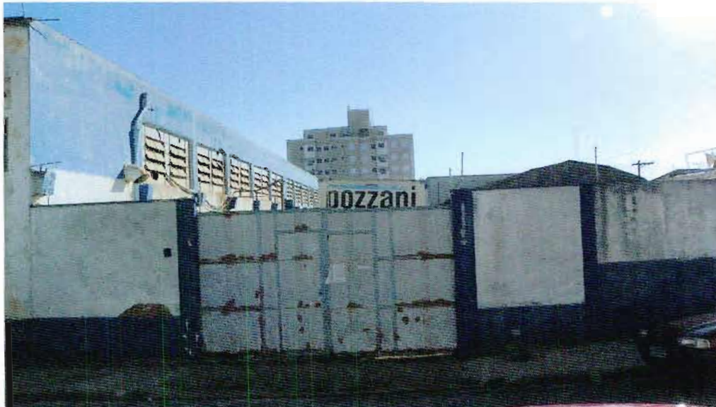
Foto 7. Portão de acesso pela rua Santo Antonio - 1
