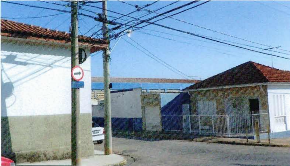
Foto 9. Vista parcial do imóvel, tomada na esquina Eloy Chaves x Santo Antonio - 1
