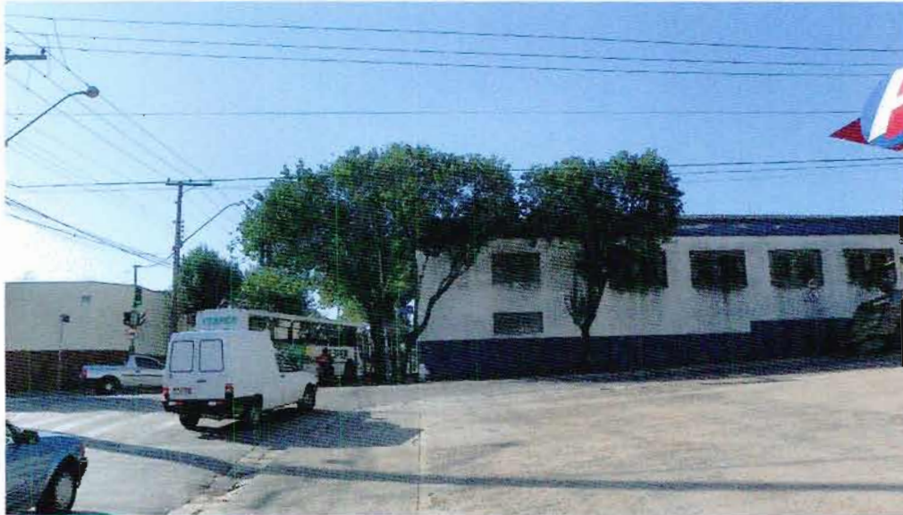
Foto 3. Vista do imóvel avaliando, na esquina das ruas Santa Maria (E) e Joaquim Nabuco (D) - 3
