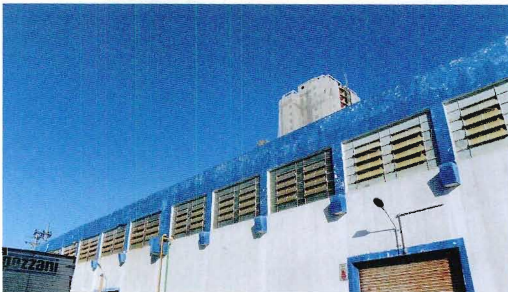
Foto 14. Lateral do galpão visto do corredor interno
