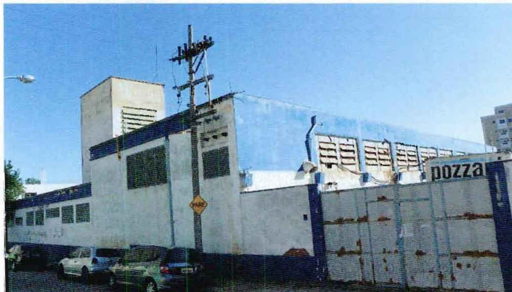
Foto 8. Portão de acesso pela rua Santo Antonio - 2
