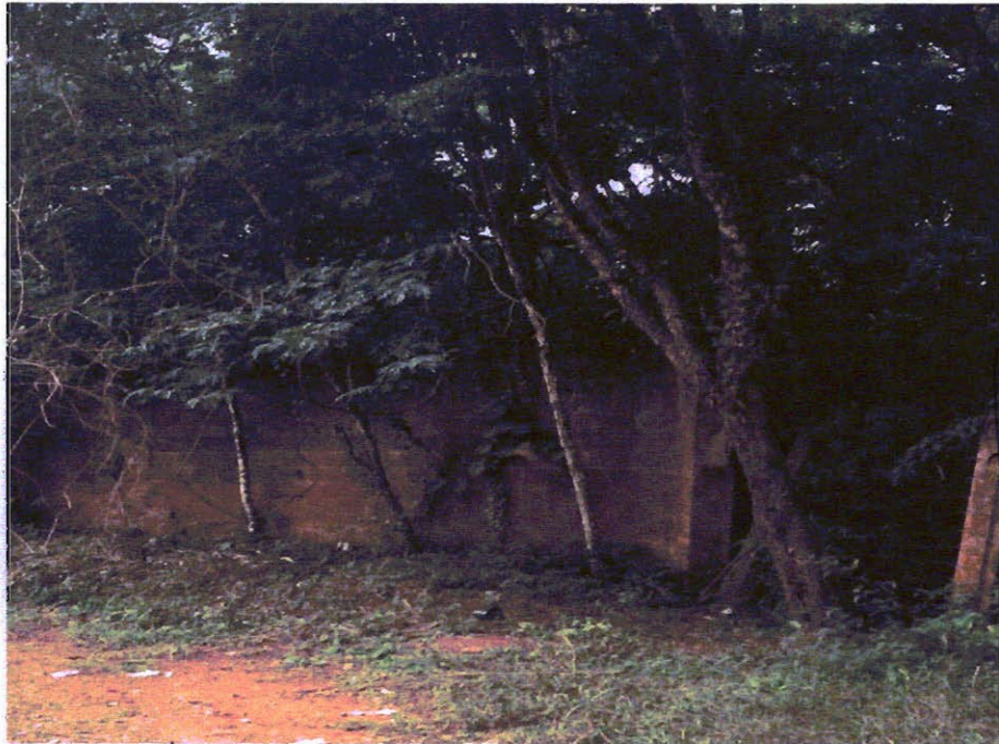
Destaque para o final do muro da cerâmica.
