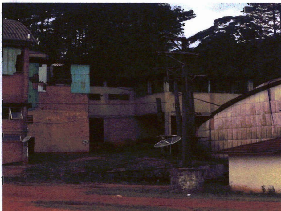
Destaque geral do péssimo estado de conservação das construções.
