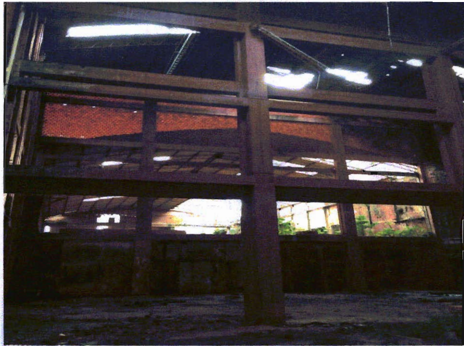
Destaque geral do galpão em péssimo estado de conservação com a estrutura tomada por ferrugem e o telhado com a estrutura e as telhas condenadas.
