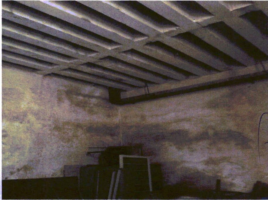
Destaque para o pavimento inferior de um dos galpões.
