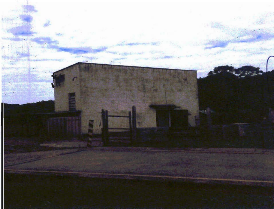
Foto que demonstra a balança e a cabine de energia.
