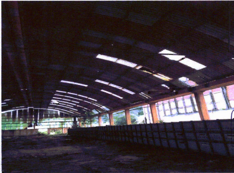
Foto que demonstra o péssimo estado do galão com a estrutura e as telhas dos telhados prejudicados, sem condições de uso. Destaque para o forno fixo no chão, também em péssimo estado de conservação e sem condições de uso.
