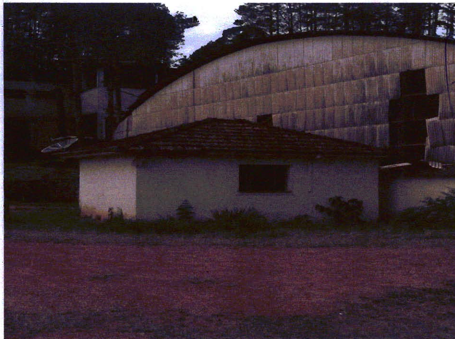
Demonstração geral do depósito.
