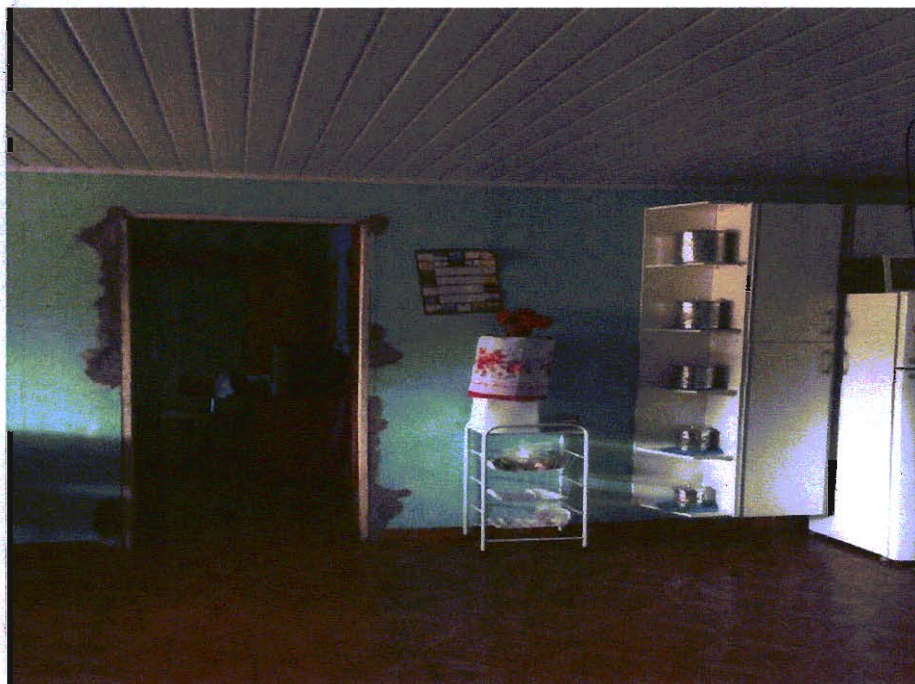
Destaque interno das escritórios adaptados para casas de moradia, com a colocação de forro e abertura de portas improvisadas.
